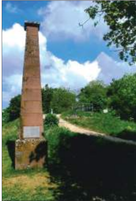
Abb. 1: Gradmessungspfeiler Dreifaltigkeitsberg. 1875 wurden auf diesem Pfeiler mit einem Theodolit Richtungsbeobachtungen zu den Dreieckspunkten Hohentwiel, Feldberg und Hornisgrinde ausgeführt.
