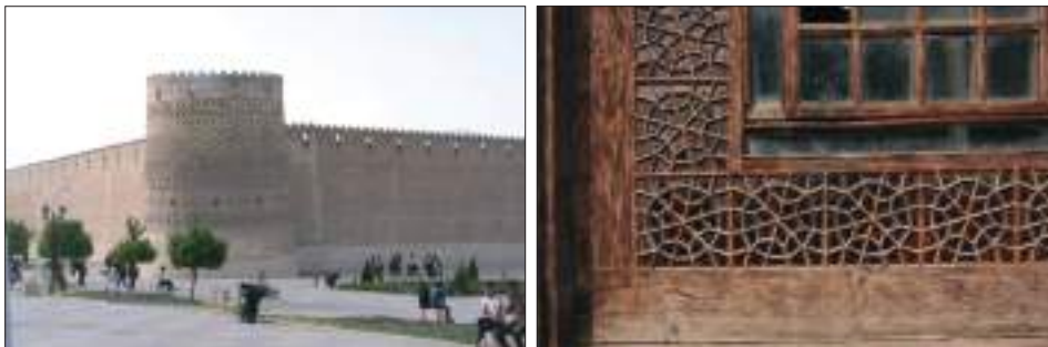
Abb. 5: Shiraz: Karim-Khan-Zitadelle (links) und in Holzleisten gefasste Glasmosaik eines Fensters (rechts)
