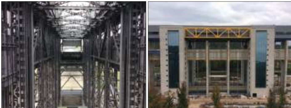
Abb. 5: Schiffshebewerk in Niederfinow
