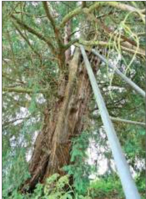
Abb. 5: Arenzhain, stählerne Abstützung (2020)
