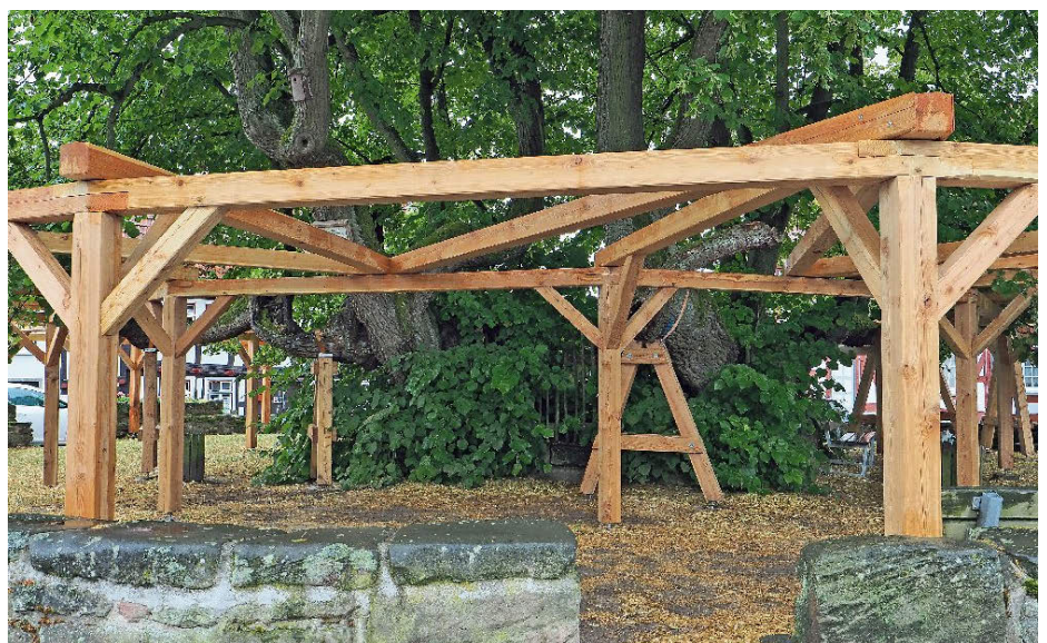
// Abb. 2: Erneuerte Stützkonstruktion zur Leitung und Abstützung der nach außen geneigten vier Stämme und ihrer Äste //
